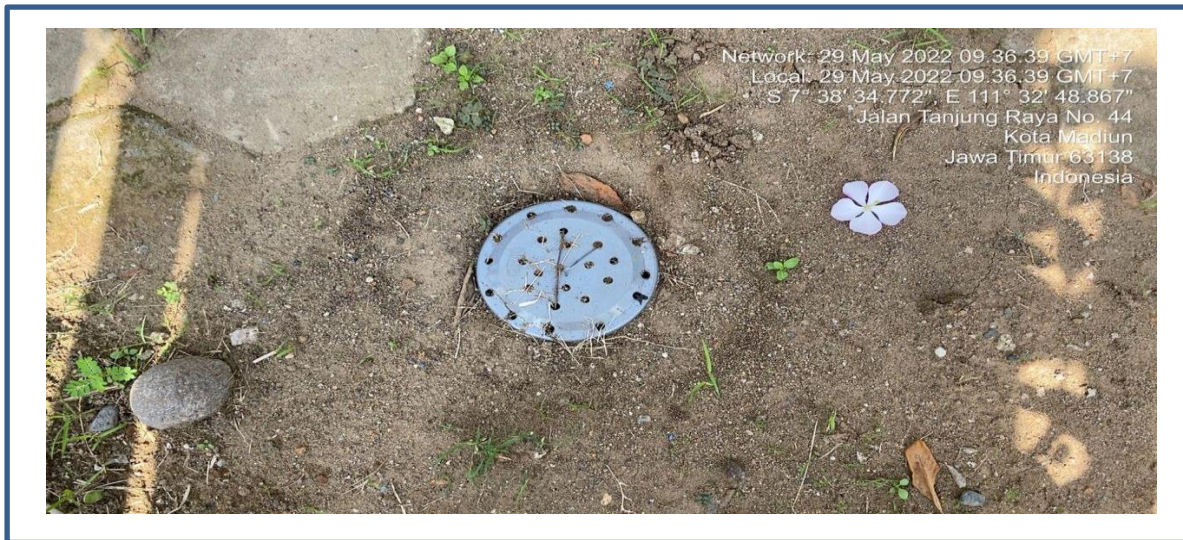
Foto 2. Biopori / Sumur Resapan / Joglangan di RW 04
