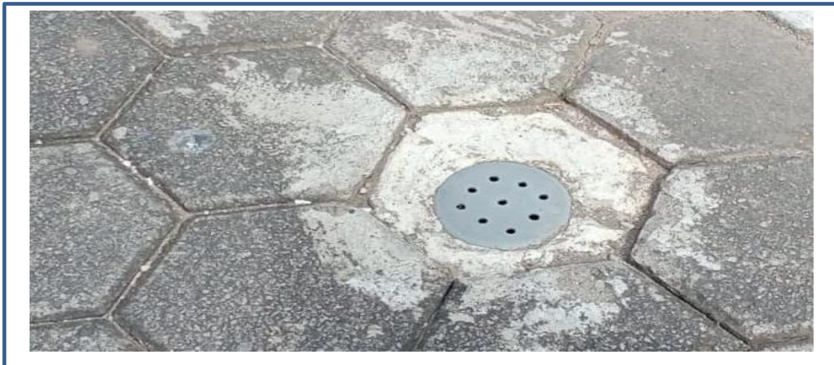
Foto 3. Biopori / Sumur Resapan / Joglangan di RW 12
