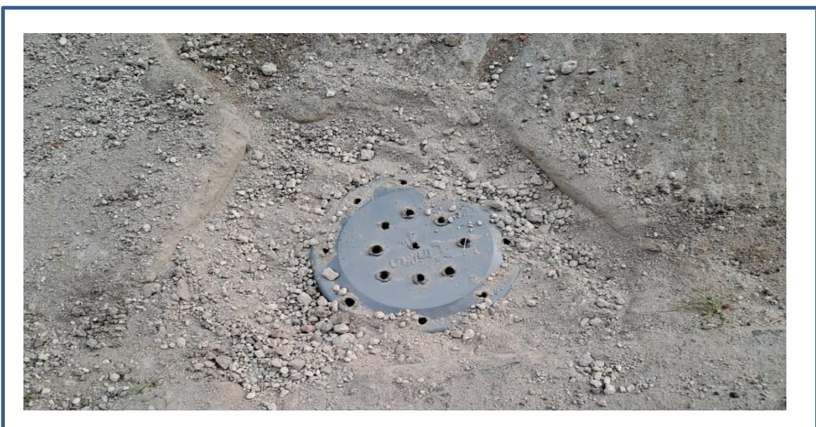
Foto 3. Biopori / Sumur Resapan / Joglangan di RW 12
